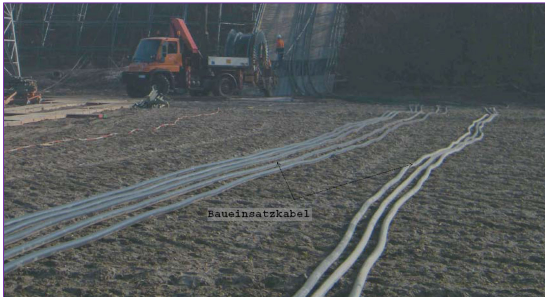
Abbildung 11: Verlegung von Baueinsatzkabeln als Provisorium für 110-kV-Leitungen
