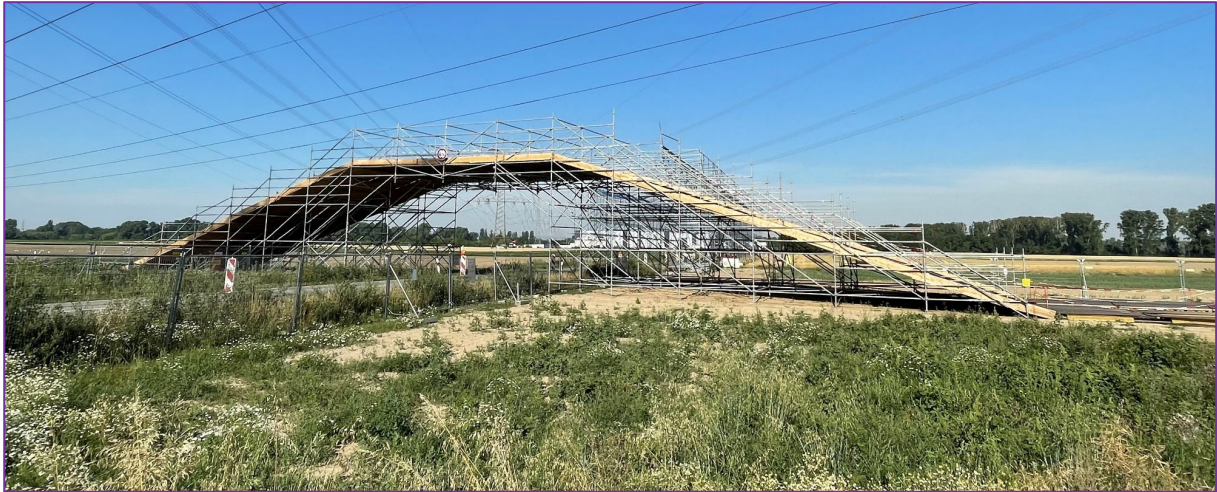
Abbildung 9: Kabelbrücke für 110-kV-Leitungen über Landesstraße
