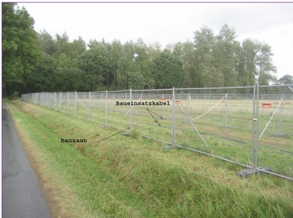
Abbildung 10: Baueinsatzkabel für 110-kV-Leitungen mit Sicherheitszaun
